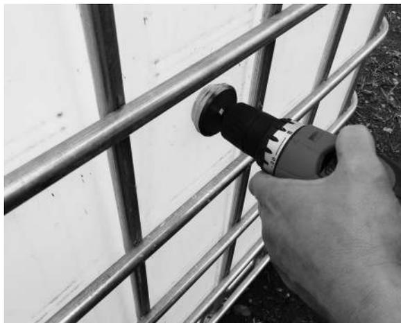
【図8 ホールソーで排水管を通す穴をあけている】
