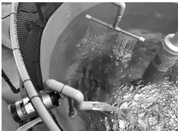
(図3-13 円形水槽に合わせて製作した給排水管)
