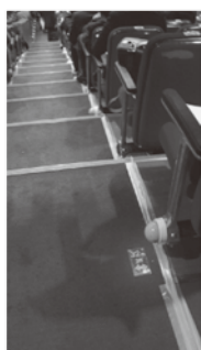
会場内の通路の床に LAN ケーブルを固定。
